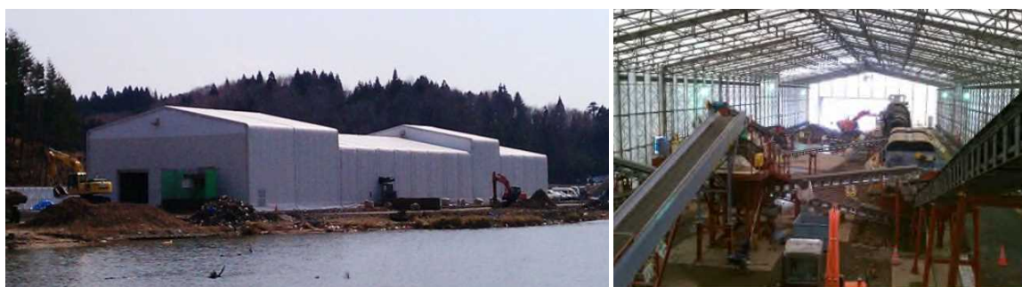
写真5-4-1 大型テント内での処理
