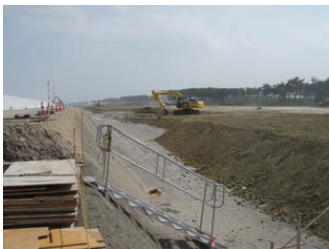
写真-2 進む防災工事
