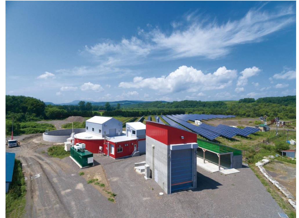
興部町の興部北興バイオガスプラント（家畜ふん尿・生ごみ・下水汚泥等）
