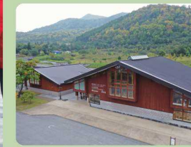
洞爺湖ビジターセンター・火山科学館 （支笏洞爺国立公園）
