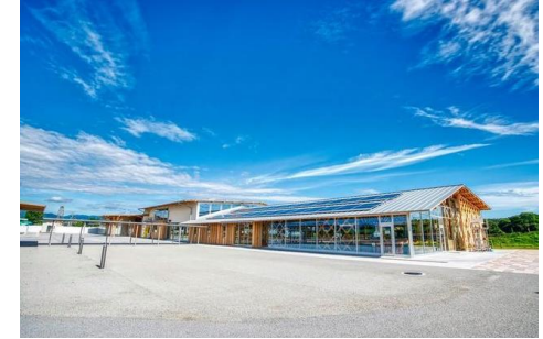
道の駅なみえ (2021年3月 グランドオープン)
