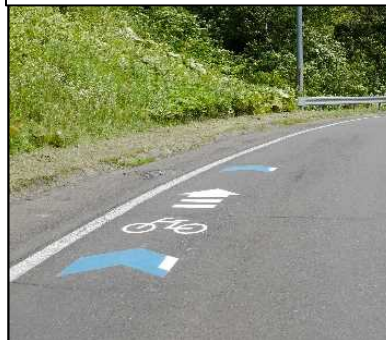
矢羽根・路面標示の設置
