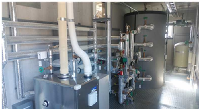
木質バイオマスバイラー（コンテナ型）内部
