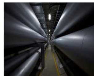
エネルギー導管
