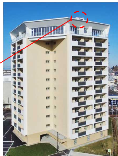
▲太陽光パネルを導入した公営住宅
