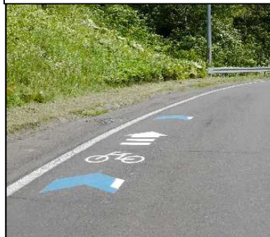
矢羽根・路面標示の設置
