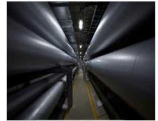
エネルギー導管
