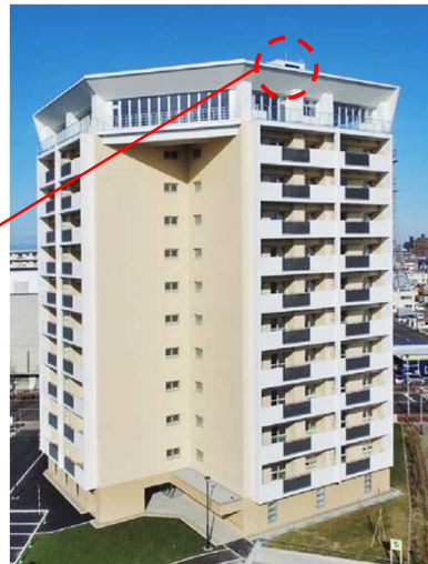
▲太陽光パネルを導入した公営住宅
