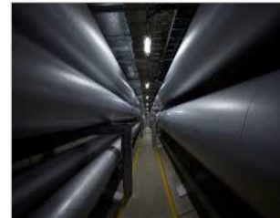
エネルギー導管
