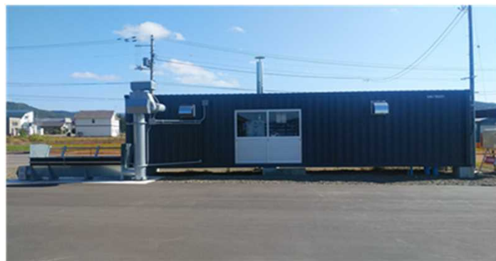
木質バイオマスバイラー（コンテナ型）外観
