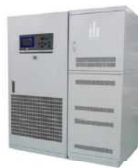
蓄電池 (エネルギー貯留施設)
