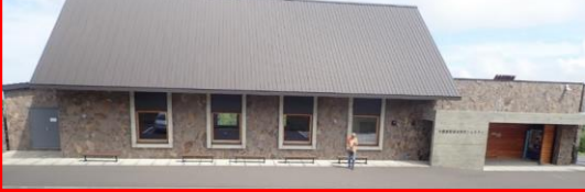
●十勝岳望岳台防災シェルター トイレ
