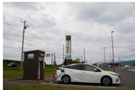
【設置例】もち米の里☆なよろ
