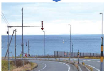
標識柱の撤去
