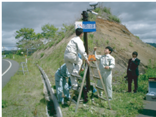
▲壮瞥町での監視カメラ設置作業
