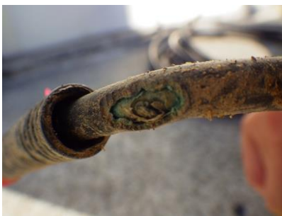
図 4. ケーブルの損傷状況
