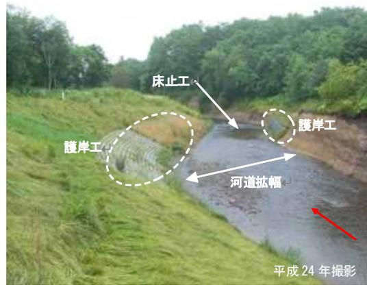
河岸侵食や河床低下が見られる久著呂川の中流部において、床止工と河道拡幅等により河道を安定させ、土砂生産を抑制することで湿原に流入する土砂量の軽減を図っています。
