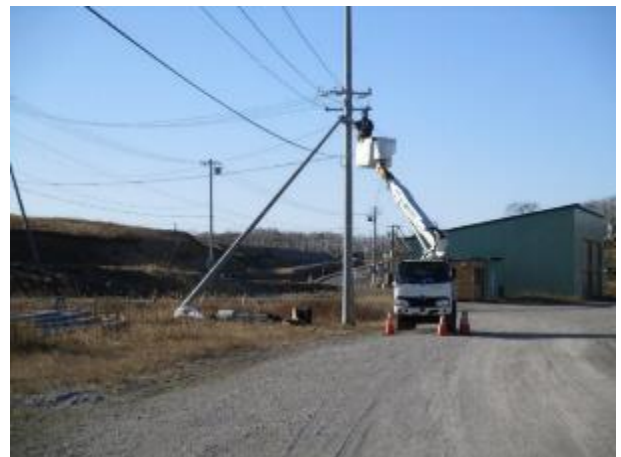
* 仮設電源引込作業 使用許可済の自家用柱を利用し電線 を設置
