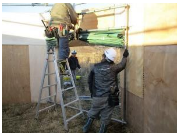
*落としゲート設置作業
