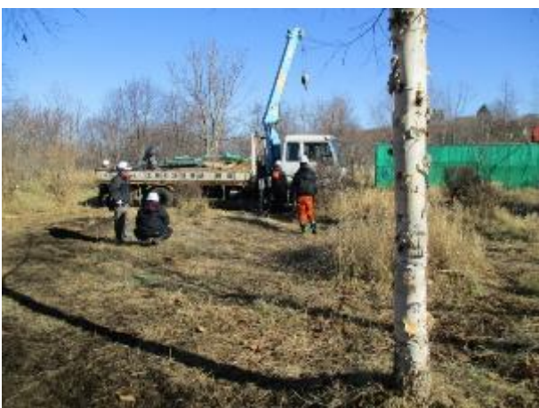
* 囲いわな撤去作業完了
