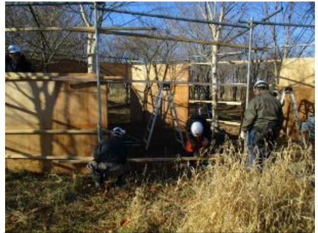
* 囲いわな撤去作業
