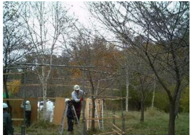
*誘引部設置作業
