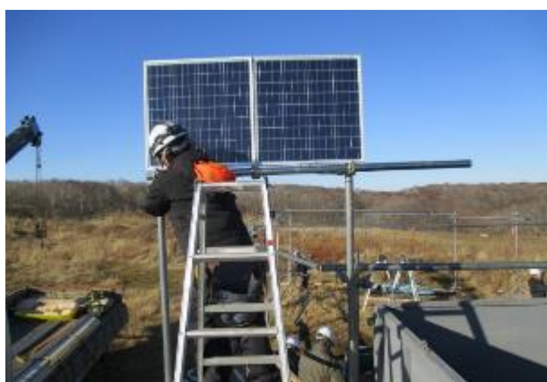
*ソーラーパネル設置作業 仮設電源引込作業終了後 100V仕様
