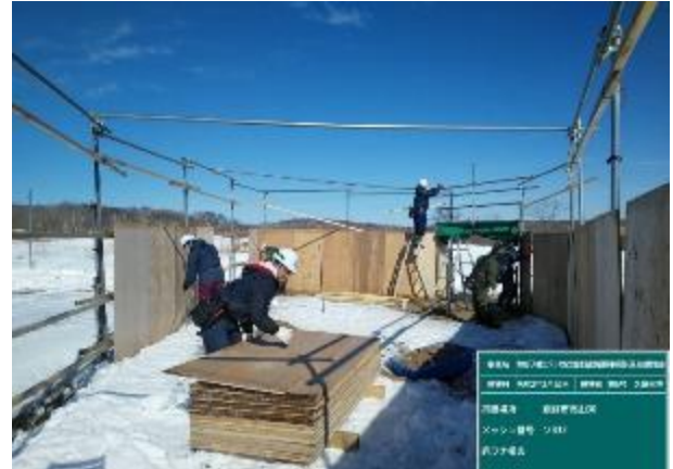
* 囲いわな撤去作業
