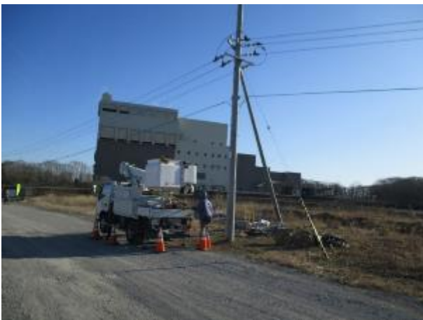
* 仮設電源引込作業 (有)佐藤電気へ委託、高所作業車にて 電柱トランスより 100V 電源引込
