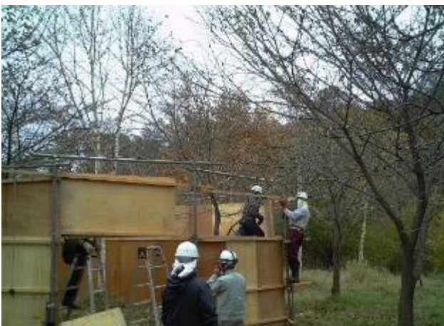
*落としゲート設置作業
