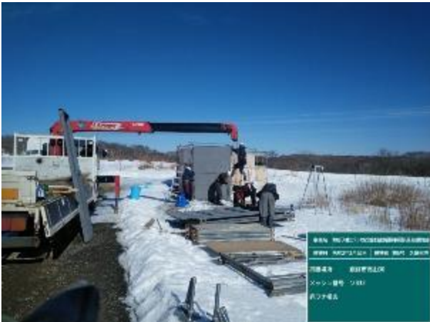
* 囲いわな撤去作業
