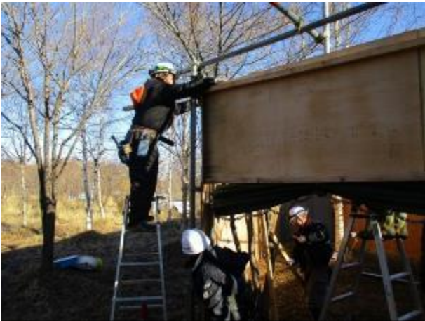
* 囲いわな撤去作業
