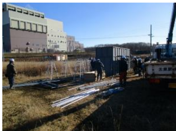
*単管パイプ設置作業
