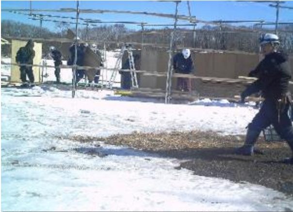
* 囲いわな撤去作業
