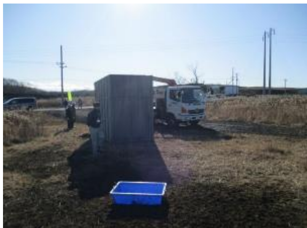
*追込み部（象の鼻）設置作業
