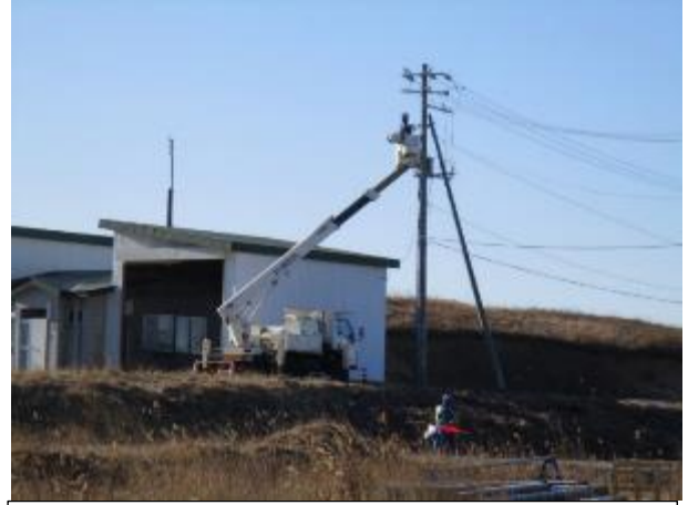
* 仮設電源引込作業 使用許可済の自家用柱を利用し電線 を設置
