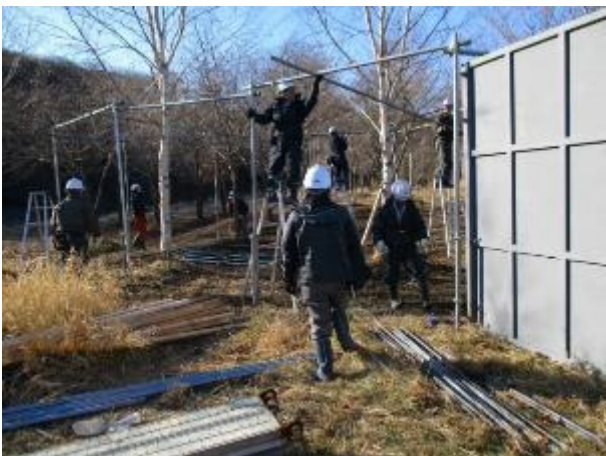
* 囲いわな撤去作業
