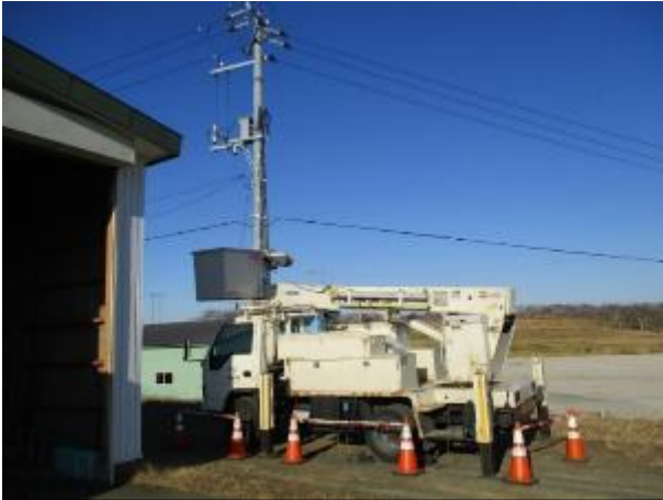
* 仮設電源引込作業 (有)佐藤電気へ委託、高所作業車にて 電柱トランスより 100V 電源引込
