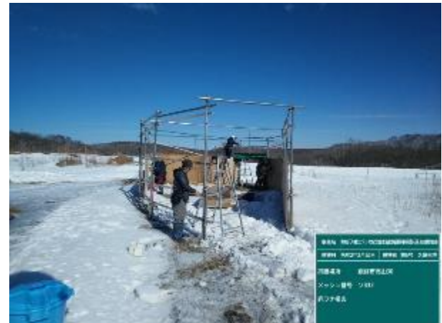
* 囲いわな撤去作業
