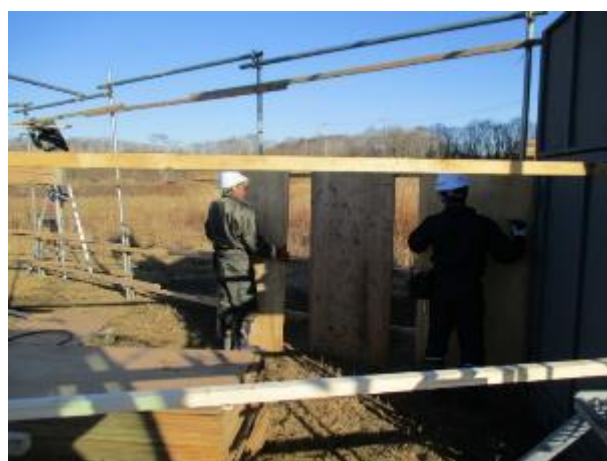
*壁部設置作業
