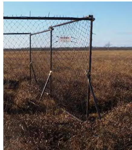
各支柱は2mの控柱で補強
