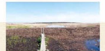
湿原の水位低下防止のための堰
