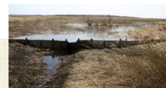
防止濕原水位低下的堰堤
