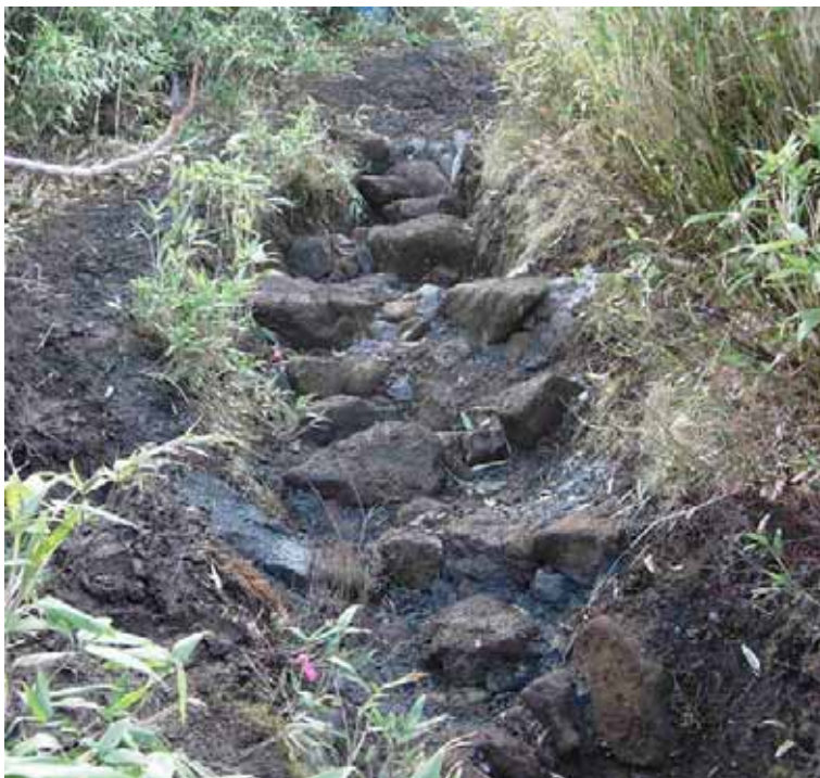
平成 17 年度施工の石組み工例（施工後）
