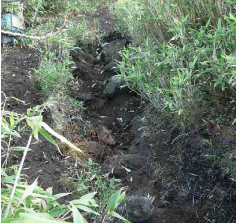
平成 17 施工の石組み工例（施工前）
