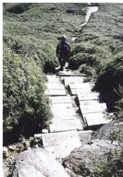
写真 45 屋久島における階段処理
