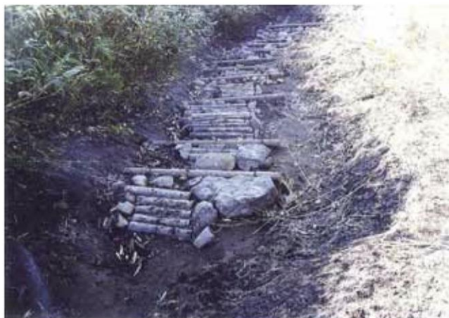
写真 44 愛山溪での丸太による階段処理
