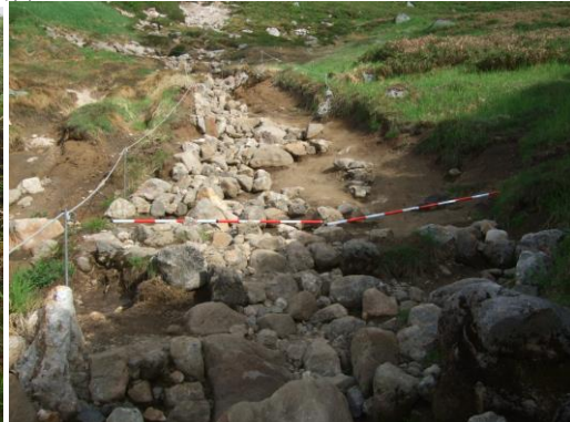
拡幅した中・急斜面の石組
