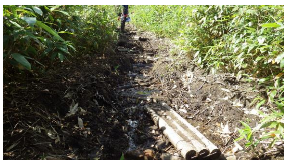
ぬかるみ箇所の修復
