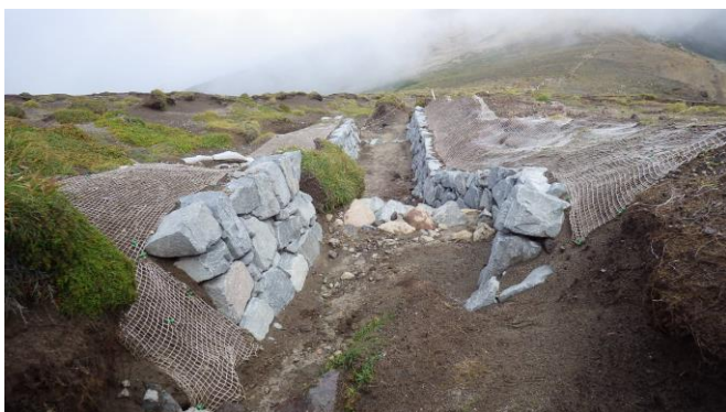
周辺からの流水が集中する箇所の石組
