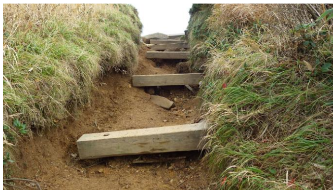
土砂が流出し木製階段が浮いている
