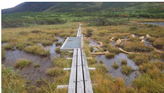
木道（隙間あり）+グレーチングの待避所
