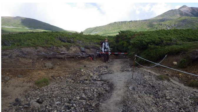
登山道拡幅・土砂流失
