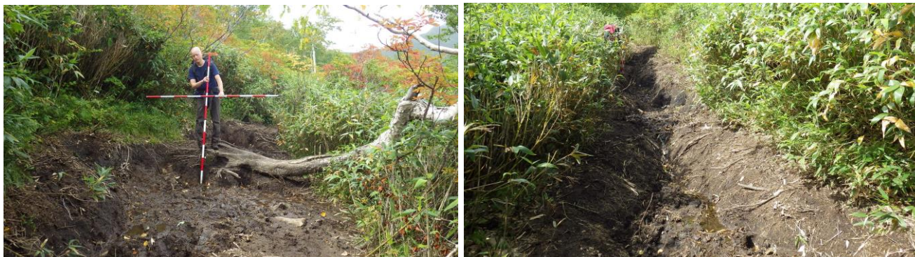
侵食により深いぬかるみが生じている
