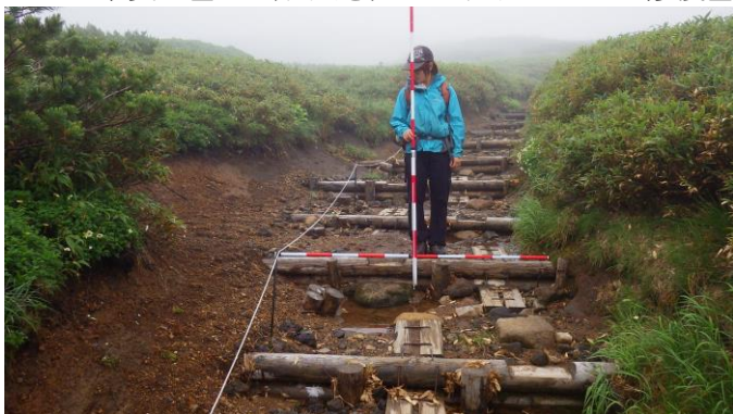
木製土留工（切欠き）+ステップ
