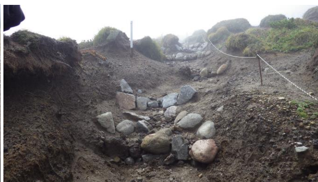
侵食された歩道の石組
