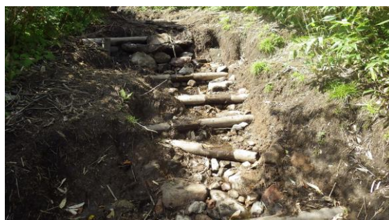
侵食箇所の修復
