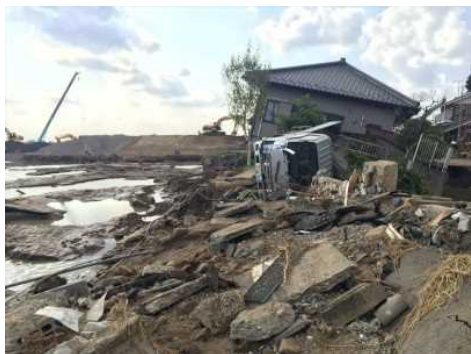
平成27年9月15日撮影 茨城県常総市 被災状況
