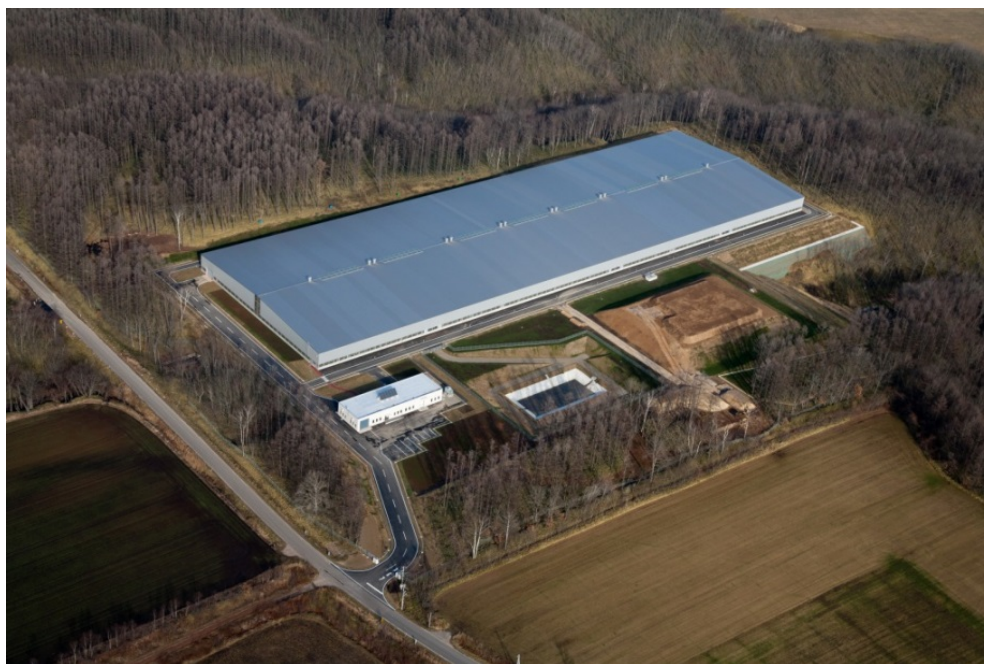
池田町のCS処分場 (屋根: 96.84 × 310.44m 容量: 約30万m 3 )
