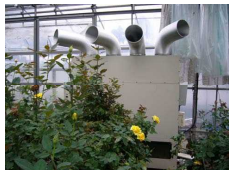
施設園芸用ヒートポンプ
