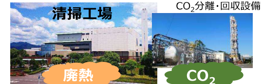
CO 2 分離・回収設備
