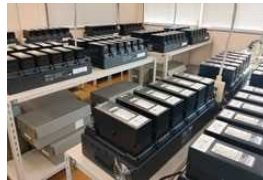
ドローンのバッテリー充電施設
