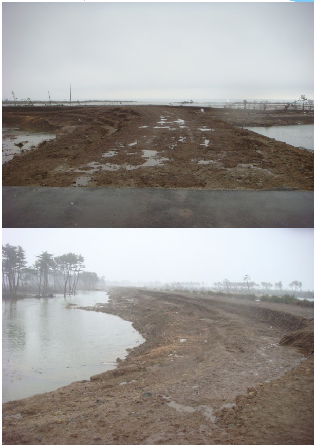
被災状況写真
