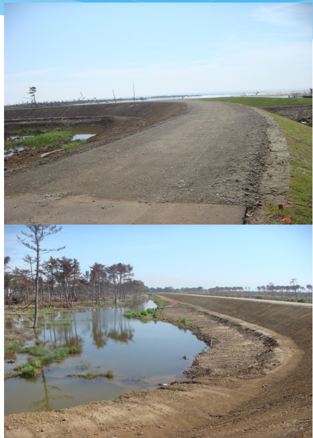
暫定復旧完了写真
