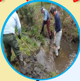
ビオトープ整備
