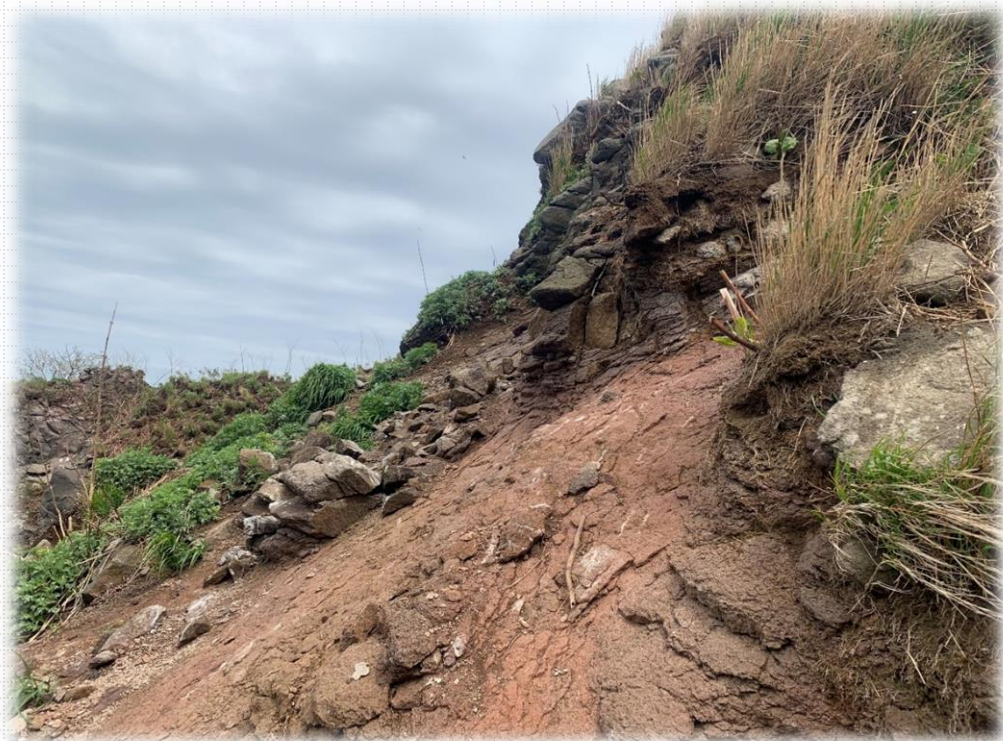
写真下部にカメラと電源を入れたコンテナを設置
