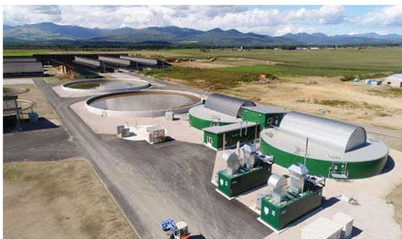
バイオガスプラント
