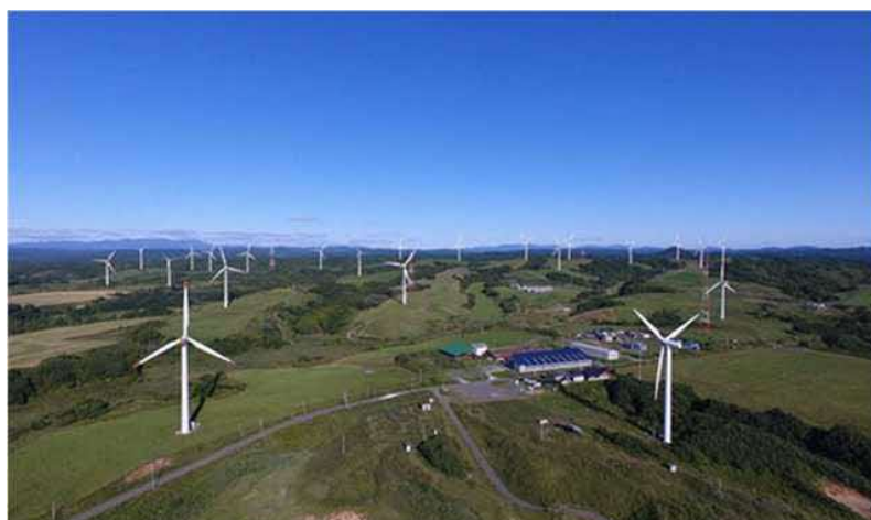
風力発電施設
