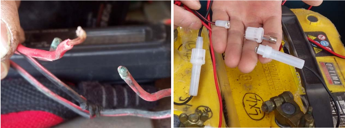
図4. (a) 2016年5月17-22日にかけての録画装置が使用できなかった原因となった太陽電池パネルの配線の腐食部（2016年5月22日修復）. (b) バッテリーの配線に装着されたヒューズホルダーの劣化による破損（2016年6月19日修復）.
