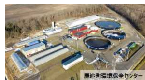
鹿追町環境保全センター
