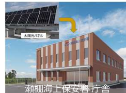
瀬棚海上保安署 庁舎
