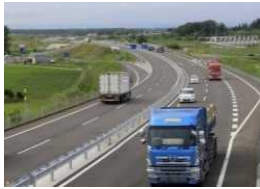
道央圏連絡道路 泉郷道路
