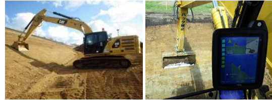
ICT建設機械での切土法面の掘削状況
