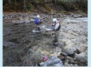
流量調査・測量作業
