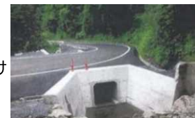
排水工の設置
