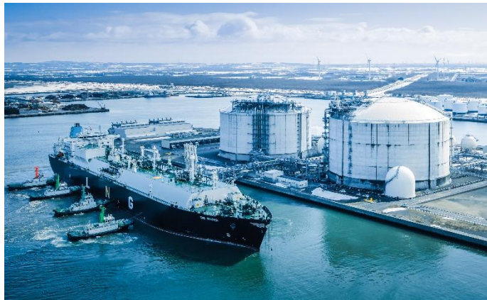
石狩LNG基地
