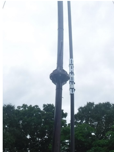
写真4-2 気象ポールの補強状況
