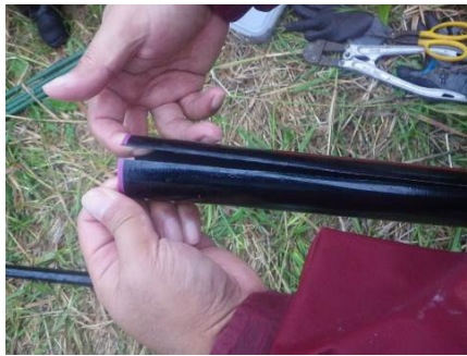
写真4-1 気象ポールの破損状況と補修後のポール
