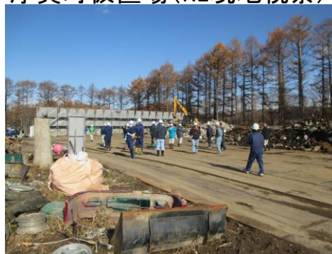
厚真町仮置場(R1現地視察)
