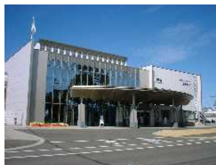
沼田町生涯学習総合センター
