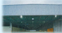
全天候型で、左右どちらにも荷下し可能な中央通路
