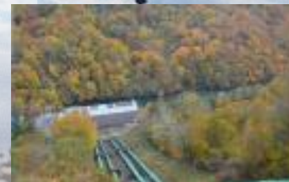
支笏湖地域の主電力 千歳第1発電所
