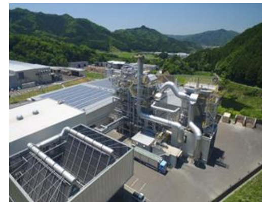
バイオマス発電施設（真庭市）
