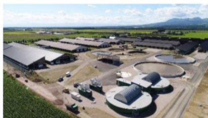
バイオガスプラント
