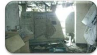
処理施設被災により 廃棄物処理の継続が困難
