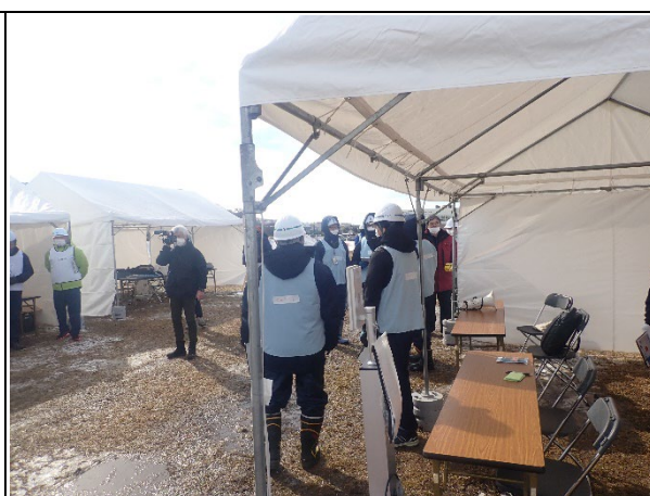
テントの設置
