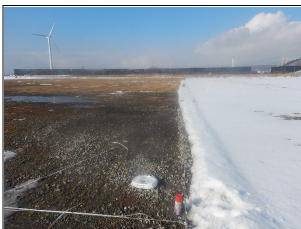
場内の広さ計測、杭・ロープの設置
