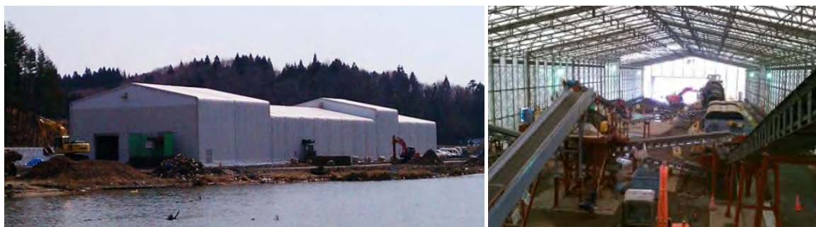
写真4-6-1 大型テント内での処理
