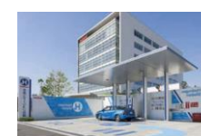
水素ステーション
