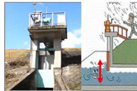
モーターでゲートを上下に開閉
