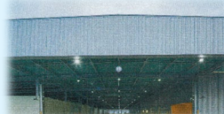
全天候型で、左右どちらにも荷下し可能な中央通路
