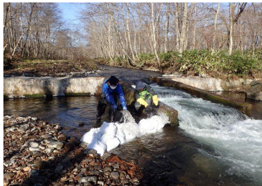
堰きとめ作業
