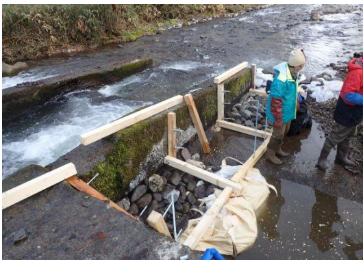
魚道組立と石の投入
