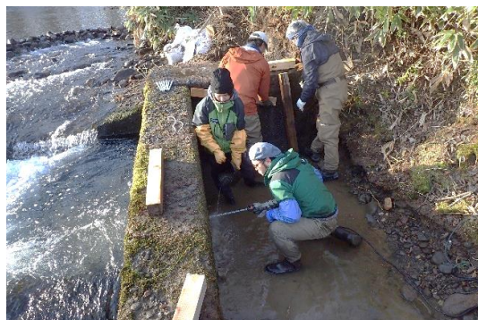
アンカーボルト設置
