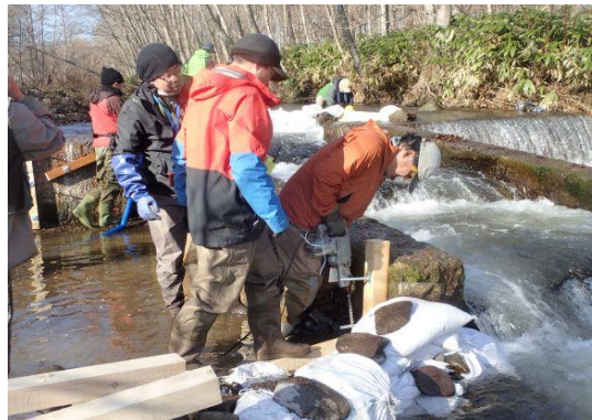
アンカーボルト設置
