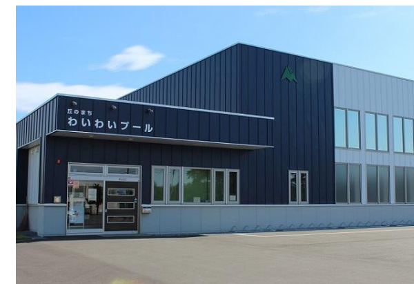
町民プール（木質バイオマスボイラー導入）
