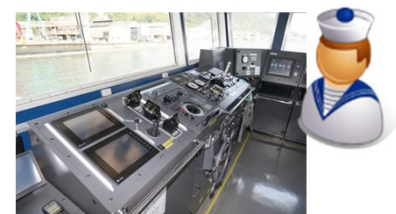
集中荷役遠隔システム
