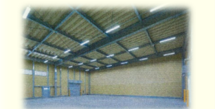
大規模流通に対応した保管施設
