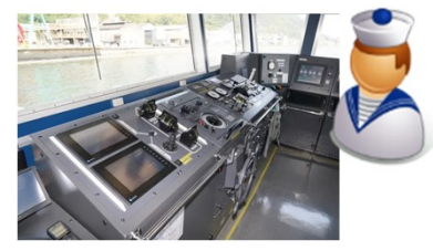
集中荷役遠隔システム
